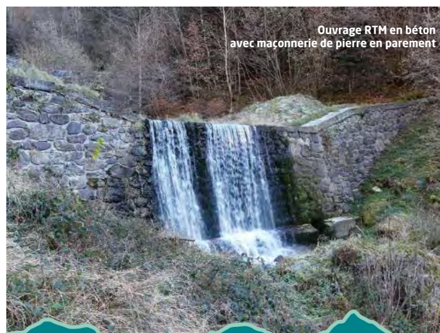
Ancien ouvrage de protection confectionné avec des pierres locales
