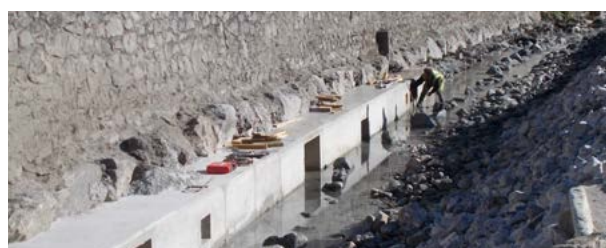
Reprise en sous-oeuvre du mur de soutènement
