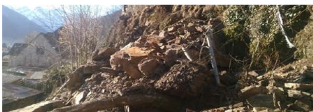
Éboulement sur la commune de Bagnères-de-Luchon obstruant un filet de protection pare-blocs (20/02/2019)
