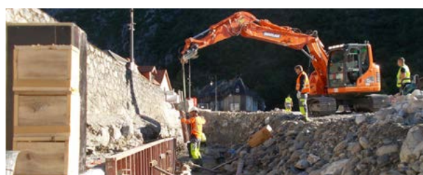
Réalisation de la longrine en rive gauche
