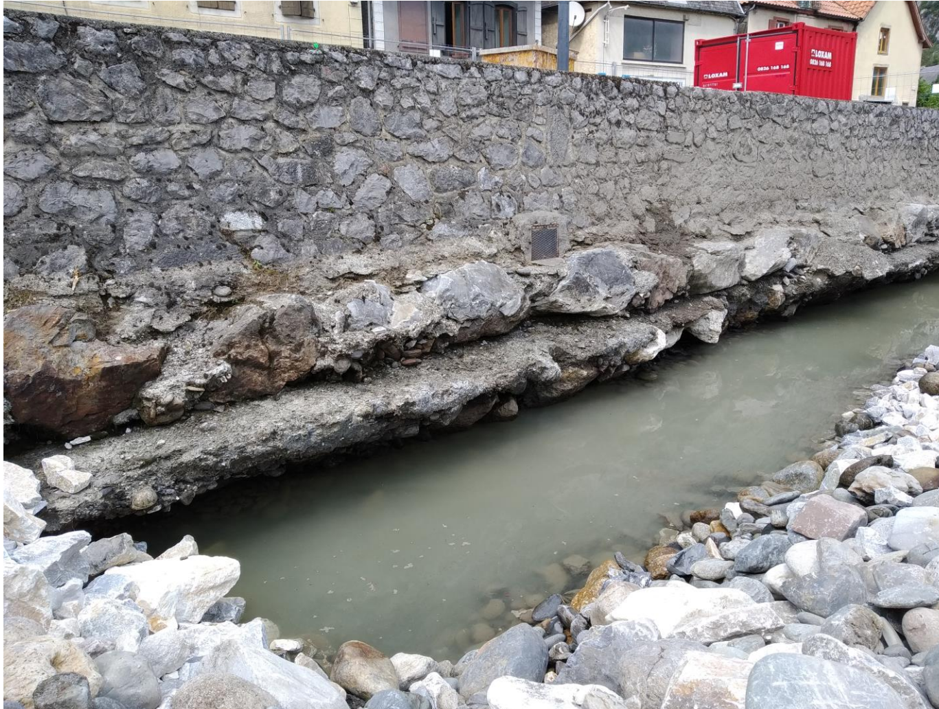
Mur-digue rive gauche aval pont-neuf
