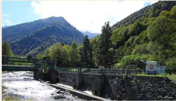
Centrale de la Pique inférieure
