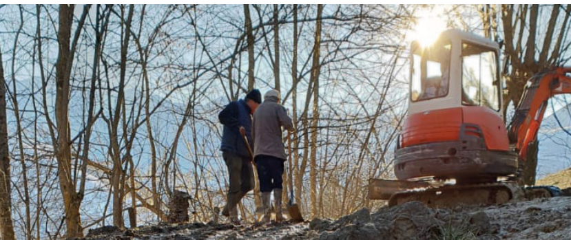
Travaux suite aux intempéries
